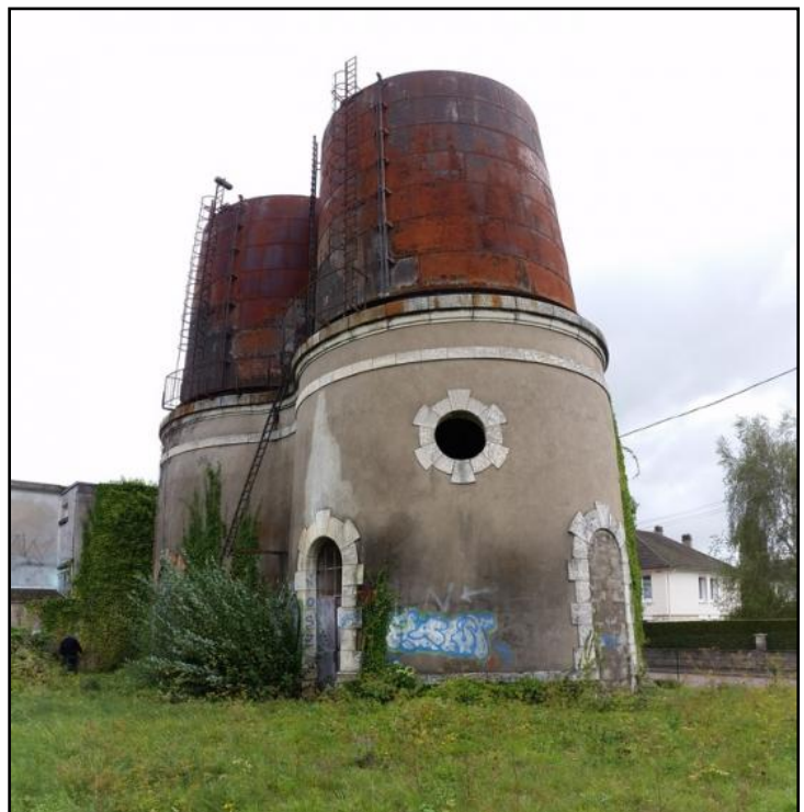
Les deux réservoirs qui servaient à alimenter les locomotives en eau
