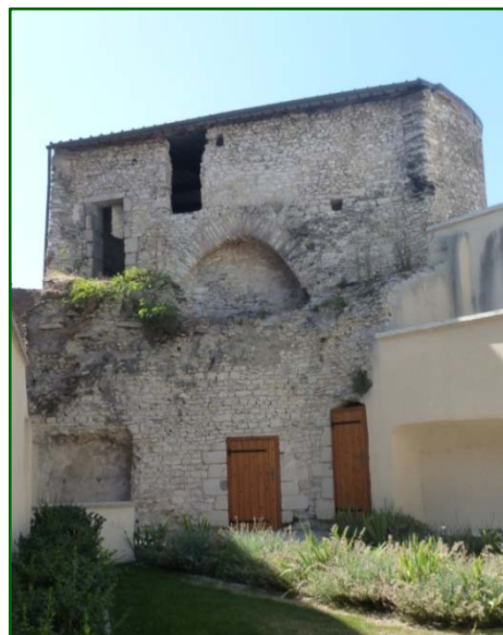
La tour dans son état actuel, côté sud
