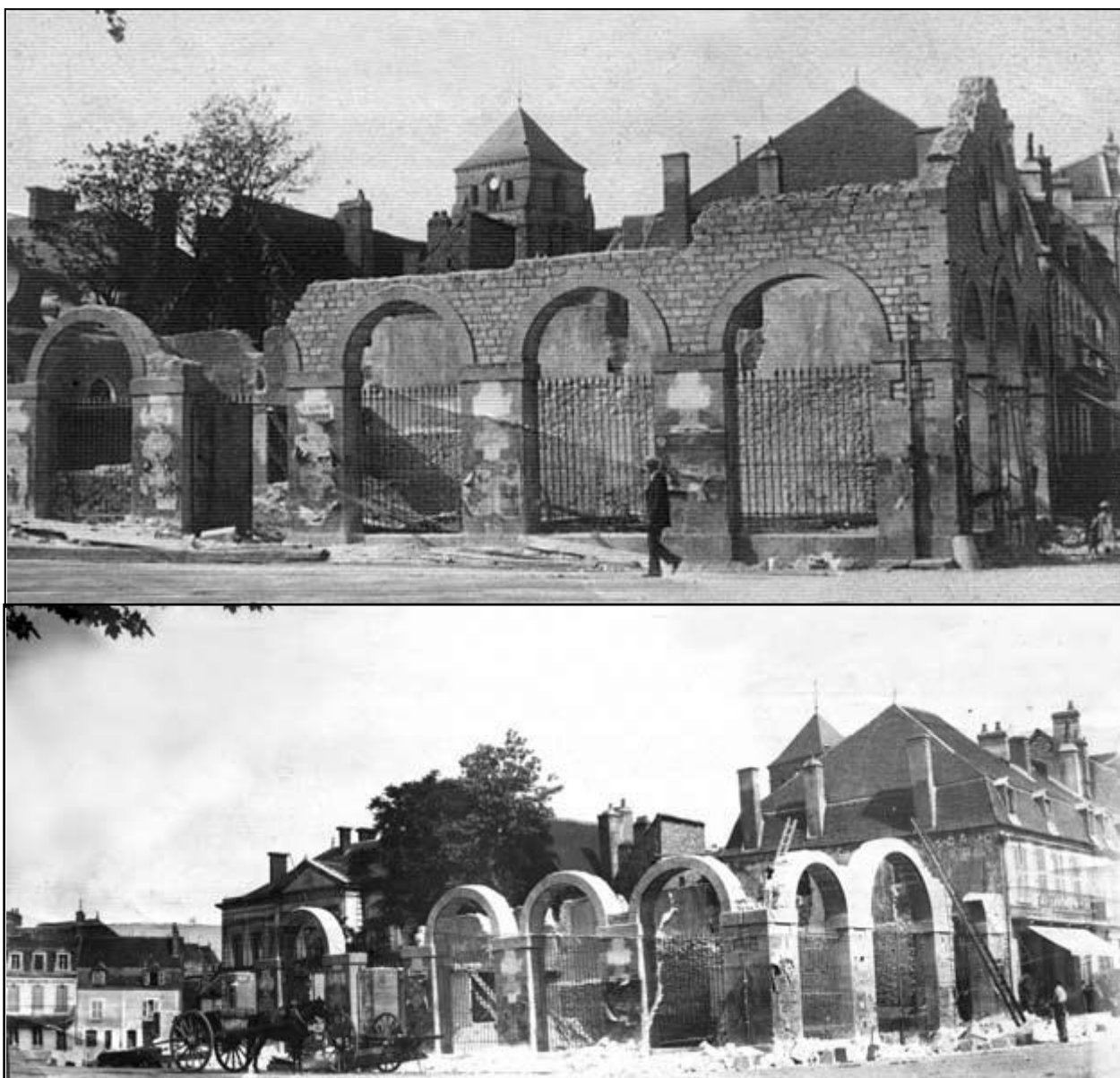
La démolition de la halle, 1901
