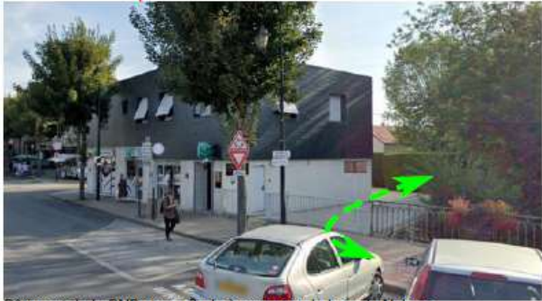
Bâtiment de la BNP et servitude à envisager le long du Nohain
